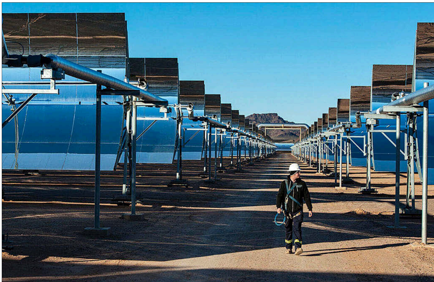
Un operario pasea por un parque solar de Atlantica en Arizona (EEUU). E.M.
